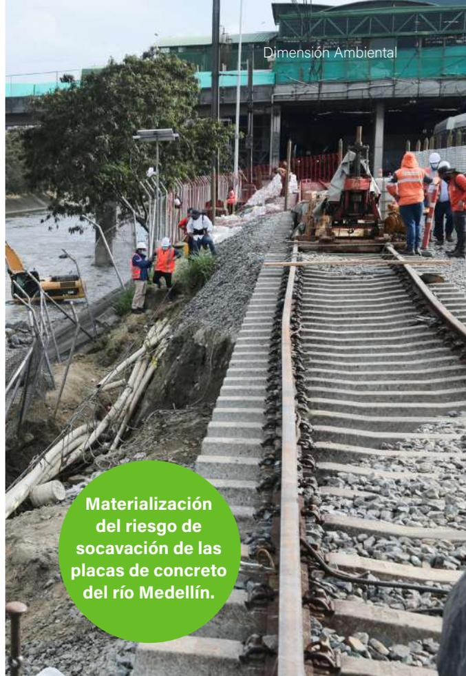
**Materialización del riesgo de socavación de las placas de concreto del río Medellín.**
