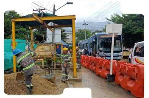
Construcción y traslado de redes mediante proceso de Tunnel Liner.
