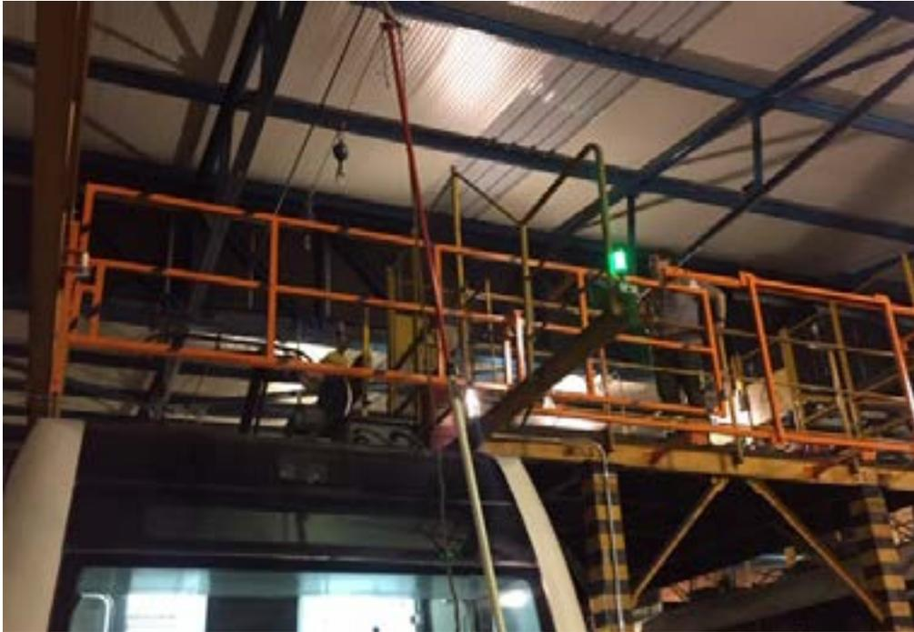
Diseñamos y construimos barreras físicas para garantizar los trabajos en el techo de vehículos de pasajeros, en la vía de los talleres, donde realizamos las intervenciones preventivas de los vehículos de pasajeros, garantizando todas las condiciones de seguridad para **trabajos en alturas**.
