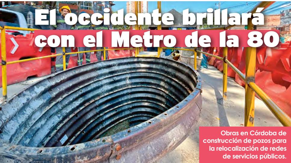
Obras en Córdoba de construcción de pozos para la relocalización de redes de servicios públicos.
