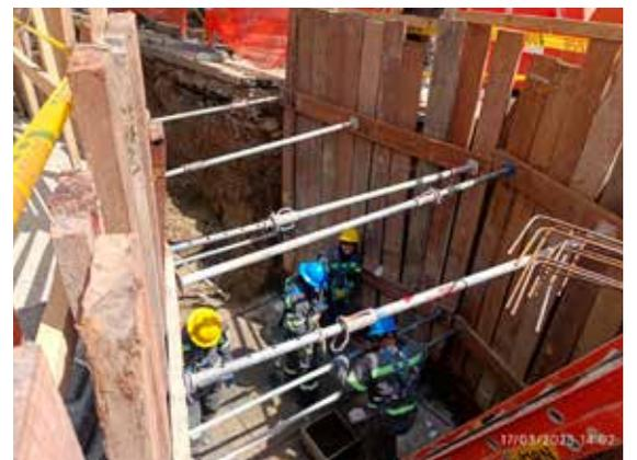
Actualmente contamos con un avance del 44% sobre la instalación de la tubería necesaria en el banco de ductos para proporcionar la energía al futuro Metro de la 80 de un total de 734,05 m de instalación previsto. Estas obras las realizamos en Calasanz donde estamos realizando varios cierres autorizados por la Secretaría de Movilidad. Allí continuamos avanzando.
