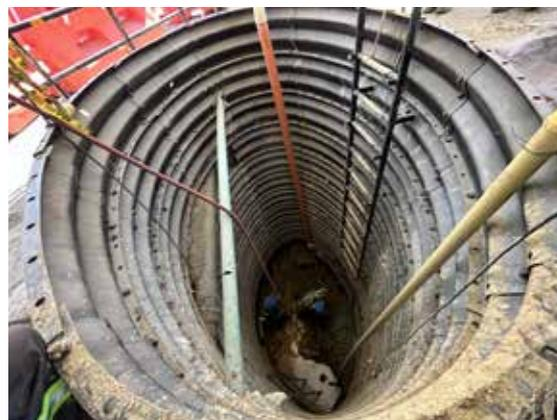
Estamos trabajando en la zona del Rinconcito Ecuatoriano para la relocalización de redes. Concluimos las perforaciones subterráneas en esta zona para continuar con la instalación de la tubería para alcantarillado. Estamos identificando otros lugares en la zona de Caribe para realizar nuevas perforaciones para las relocalizaciones de redes.
